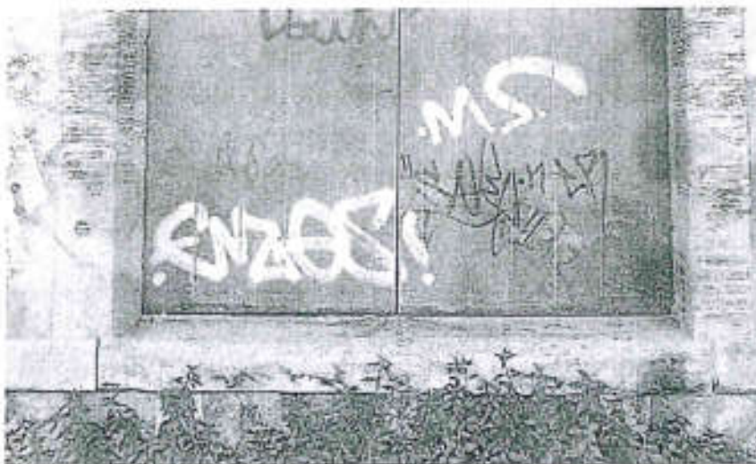
Εικόνα 29: Θύρα στην βόρεια όψη με συμπλήρωση των σπτόπλινθων με τσιμεντοκονίαμα.
