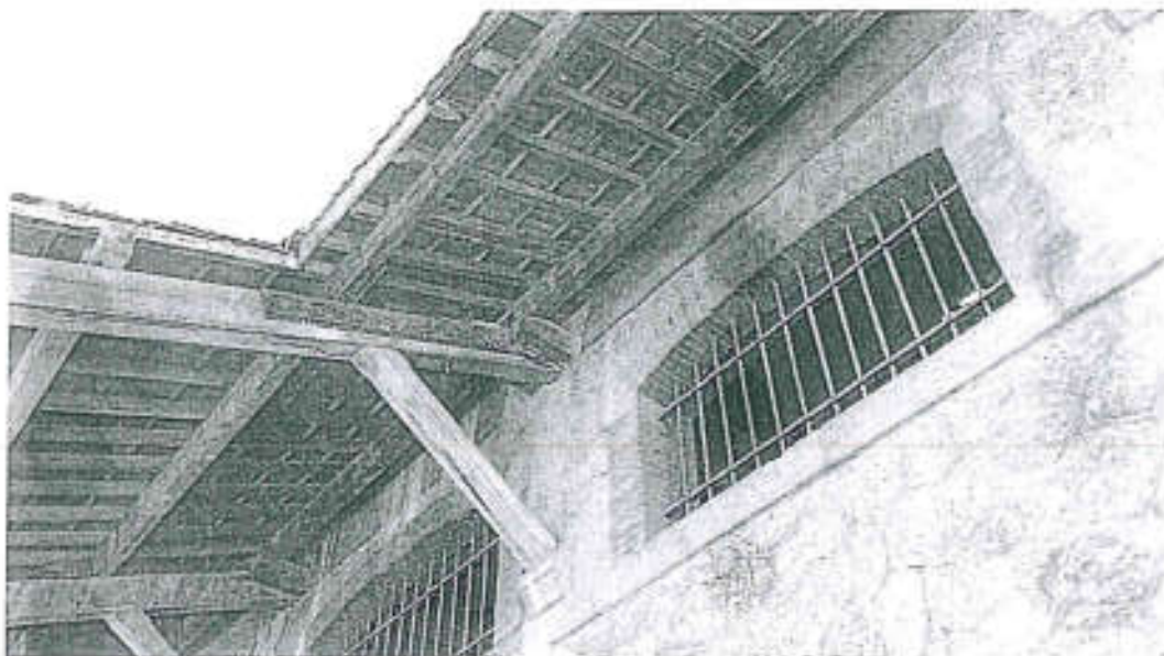
Εικόνα 22: ΝΑ γωνία προστεγάσματος με βλάβες σε πρόβολο και τειγίδα.
