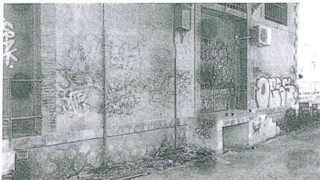
Εικόνα 19: Αρμολογήματα με τσιμέντο στην βόρεια όψη.
