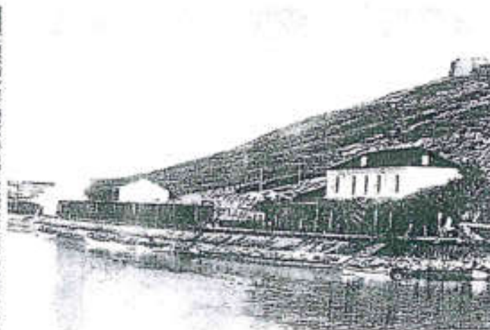
Εικόνα 2: Φωτογραφία κτηρίων Αποθηκών (αριστερά) και Σταθμού ΟΣΕ, 1905
