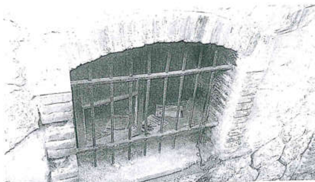
Εικόνα 33: Παράθυρο υπογείου με μεταλλικά κγκλιδώματα προστασίας.
