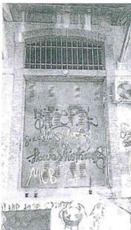
Εικόνα 30: Μεταλλική θύρα στην δυτική γωνία της βόρειας όψης.
