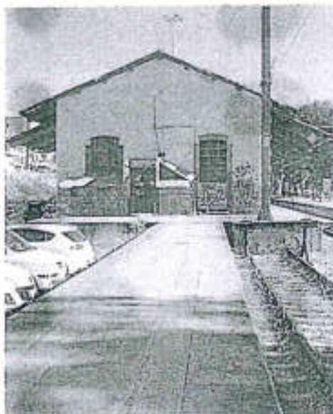
Εικόνα 5: Δυτική όψη κτιρίου
