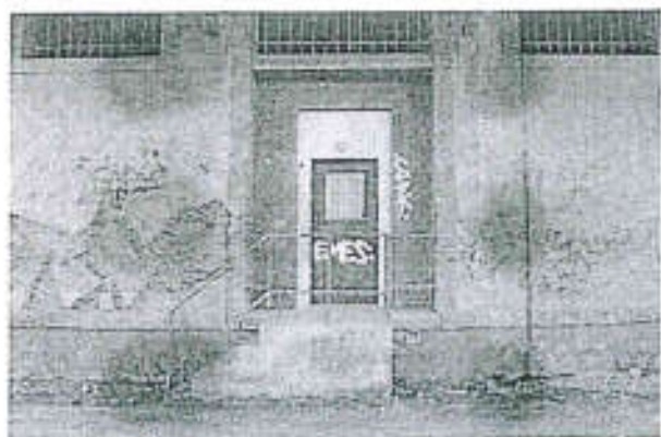
Εικόνα 14: Μετασχηματισμός θύρας και διαμόρφωση βόθρου από σκυρόδεμα
