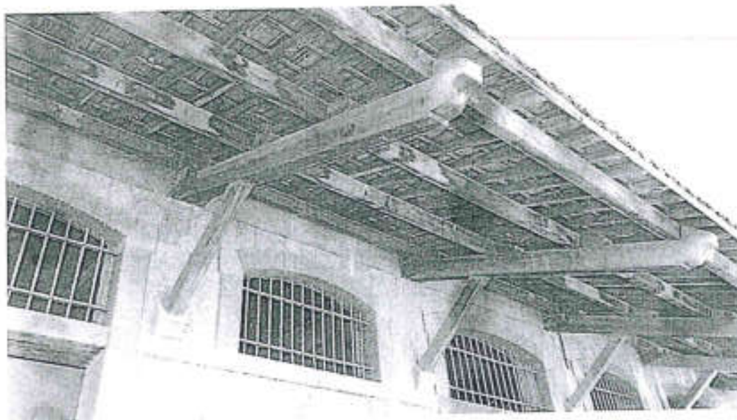
Εικόνα 32: Παράθυρα (φωταγωγοί) με μεταλλικά κγκλιδώματα προστασίας.
