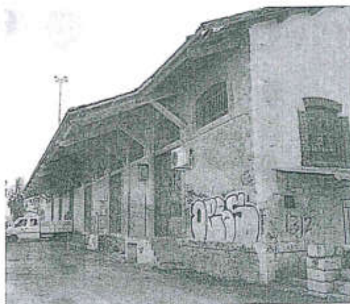
Εικόνα 4: Βορειοδυτική άποψη κτιρίου
