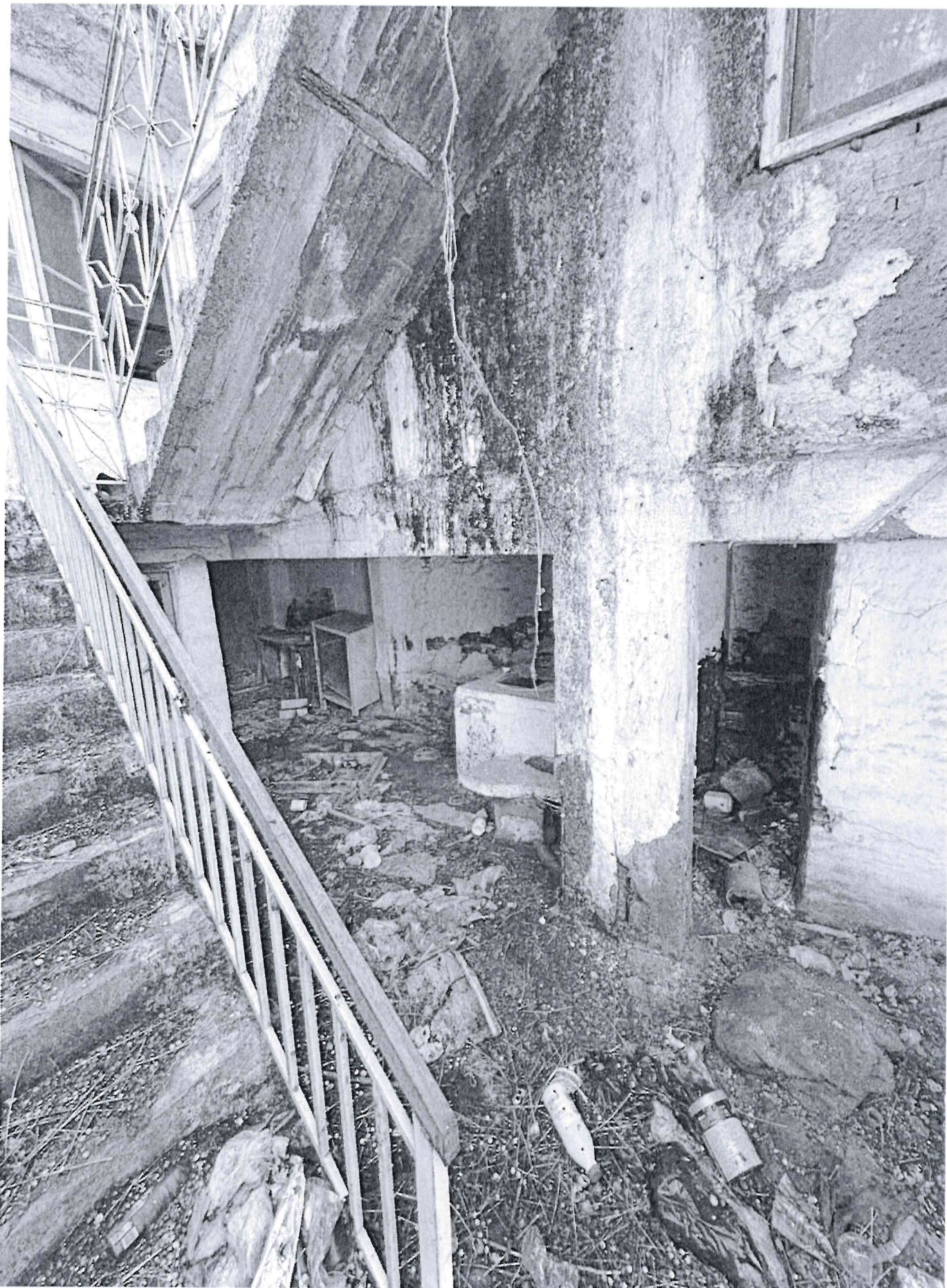
Εικ. 21: Κεντρικό υποσύλωμα-κρίσιμο για την στήριξη του μεγαλύτερου τμήματος του κτιρίου στην εσωτερική αυλή του
